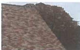
Toiture chamarrée par le mélange des tuiles
