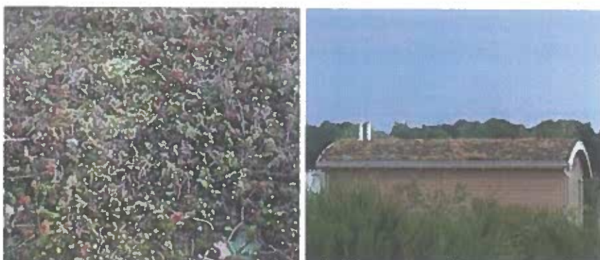
Toit végétalisé sur une maison d'habitation contemporaine.
